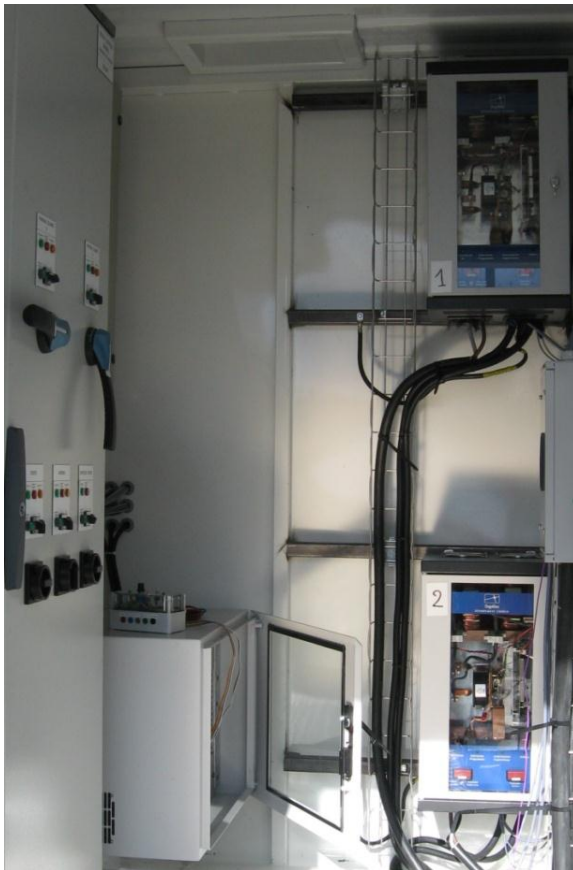
Un convertisseur DC-DC par champ de panneaux
