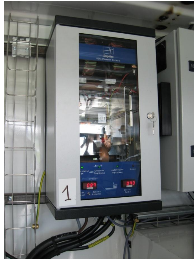
Un convertisseur DC-DC par champ de panneaux
